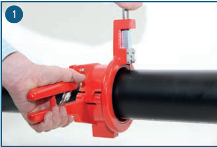
1 De PE buis haaks afsnijden of zagen, verwijder bramen en of vuil.
