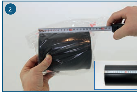
2 Meet de insteekdiepte van de fitting, tel er 20 mm bij en markeer dit op de PE buis.
