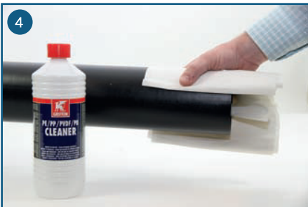
4 Maak de PE buis schoon met PE reiniger en laat de buis goed drogen. Raak vanaf nu het lasoppervlak niet meer aan.
